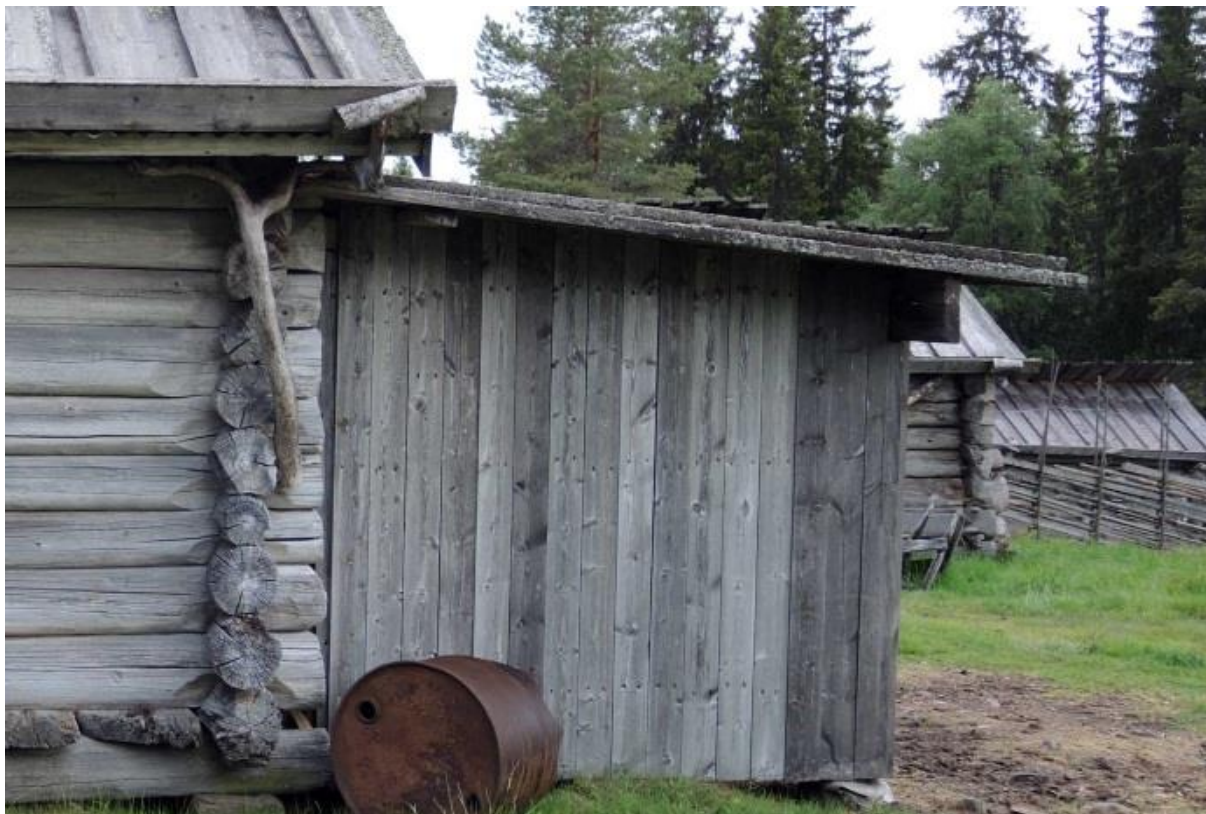
En tillbyggnad av regelverksstomme med jämsågade och smala bräder ger ett modernt intryck, till skillnad från den robusta timmerstommen intill.
