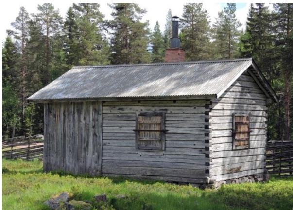
Byggnad DM 3 med sinuskorrugerad takplåt, nocktäckning av plåt och obehandlade vindskivor.
