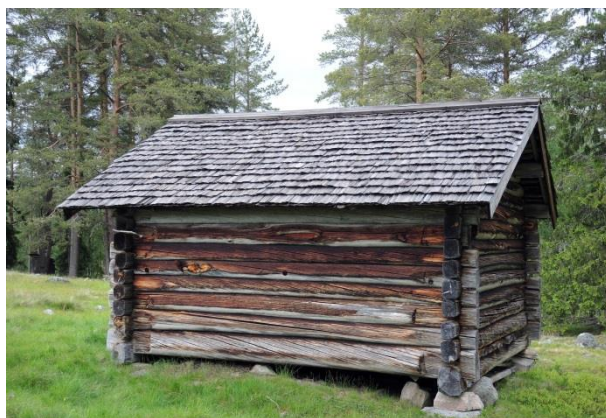
Byggnad nr 17 är idag den enda med pärttak, vilket var betydligt vanligare på Hedbodarna i början av 1900-talet.
