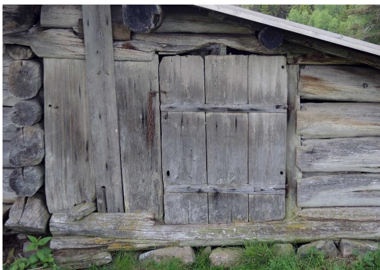
Enkel bräddörr, byggnad nr 15.
