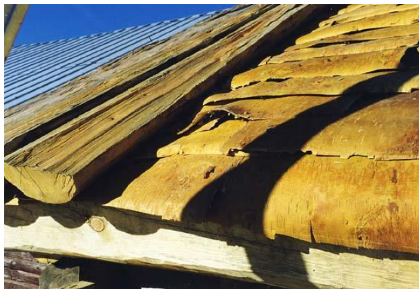
Exempelbild som visar flera lager näver med ovanpåliggande halvklover, notera att kärnveden är vänd uppåt. Bildkälla:
