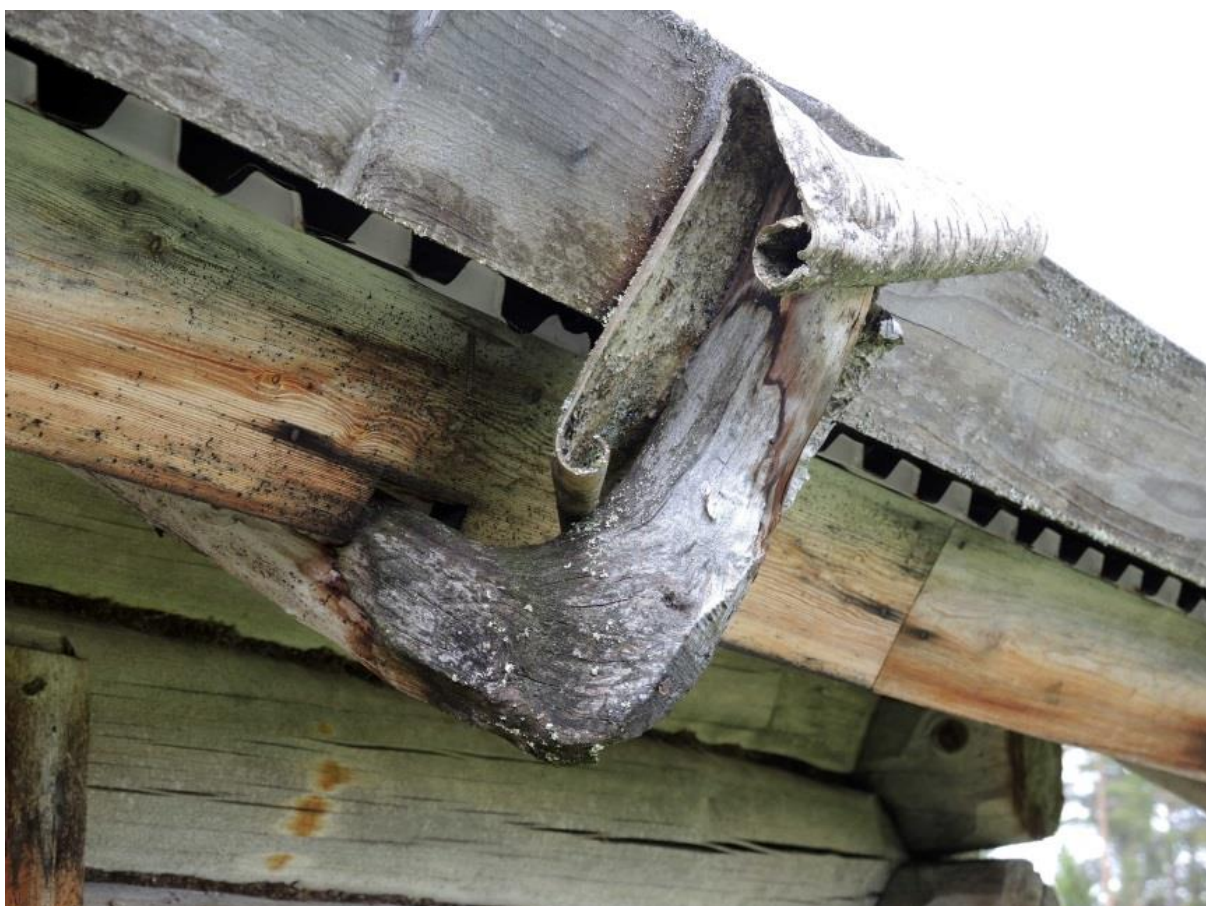
Naturligt krokvuxet virke har använts till raftkrok. De vilar på takåsarna och bär upp täckjan som stöd åt takveden.
