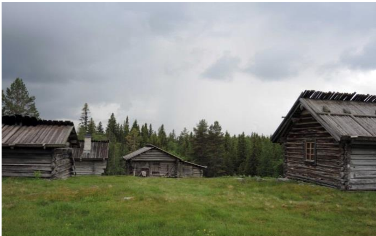
Bebyggelse under sentida bräd- och vedtak, på takten i sydväst.
