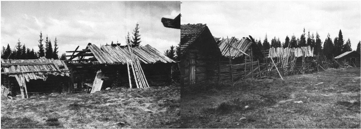
Till vänster; Eldhus och mjölkbod, troligen före restaureringen 1943, till höger; fähus före restaurering samma år.
