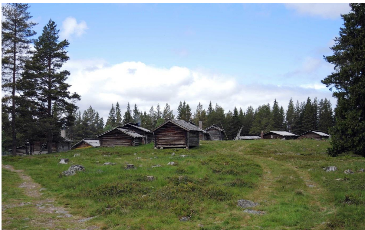
Vy från ingången i öst. Den ålderdomliga karaktären med grått timmer och träklädda sadeltak över små timmerkonstruktioner är påtaglig. Tack vare fäbodmiljöns välbevarade timmerstommar och byggnadsdetaljer blir ett besök i miljön en tidsresa.
