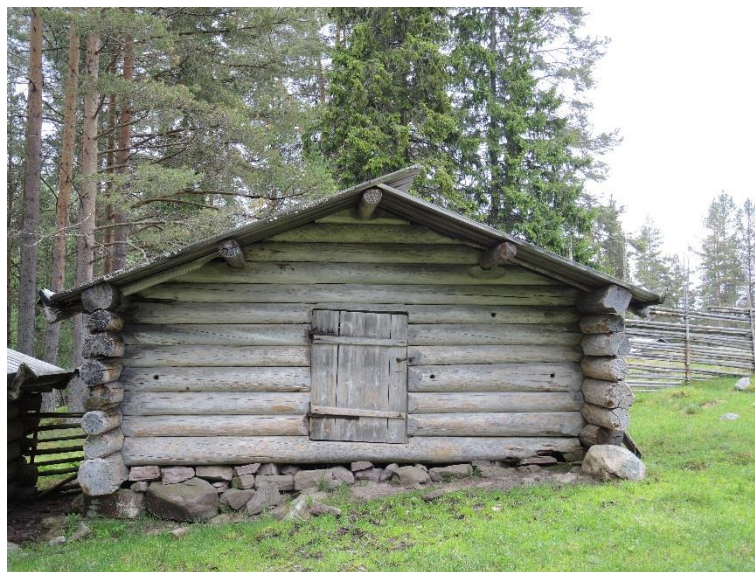
Fähus, byggnad 34, med plockstensgrund. Stora plockstenar fyller ut utrymmet mellan mark och syllstock, här i en sluttning.
