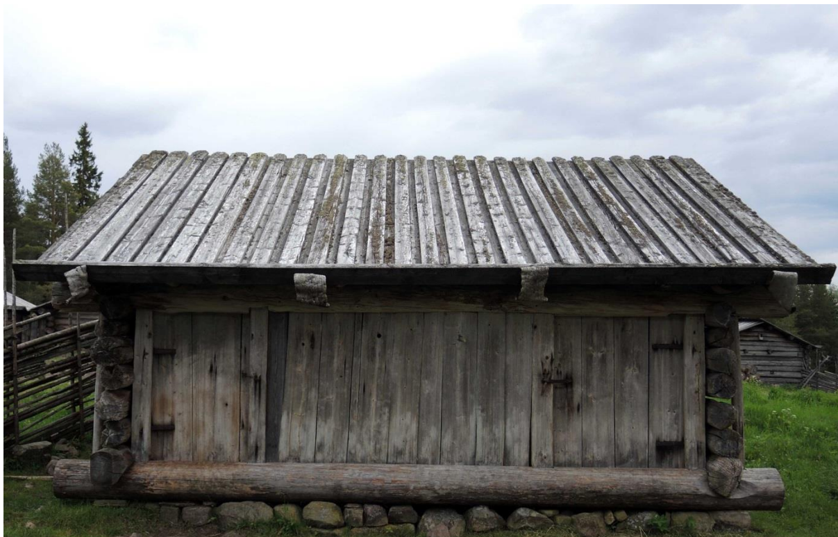
Byggnad nr 4, ett kombinerat stall med foderbod, har bebyggelsemiljöns enda stavkonstruktion. På brädernas insida syns det tydligt att bräderna är spräckta, medan träets fibrer vittrat till en slät yta på utsidan
