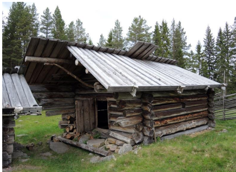
Byggnad 1, Eldhus, t.v. tillhörande mjölkbod. Vy från söder.
