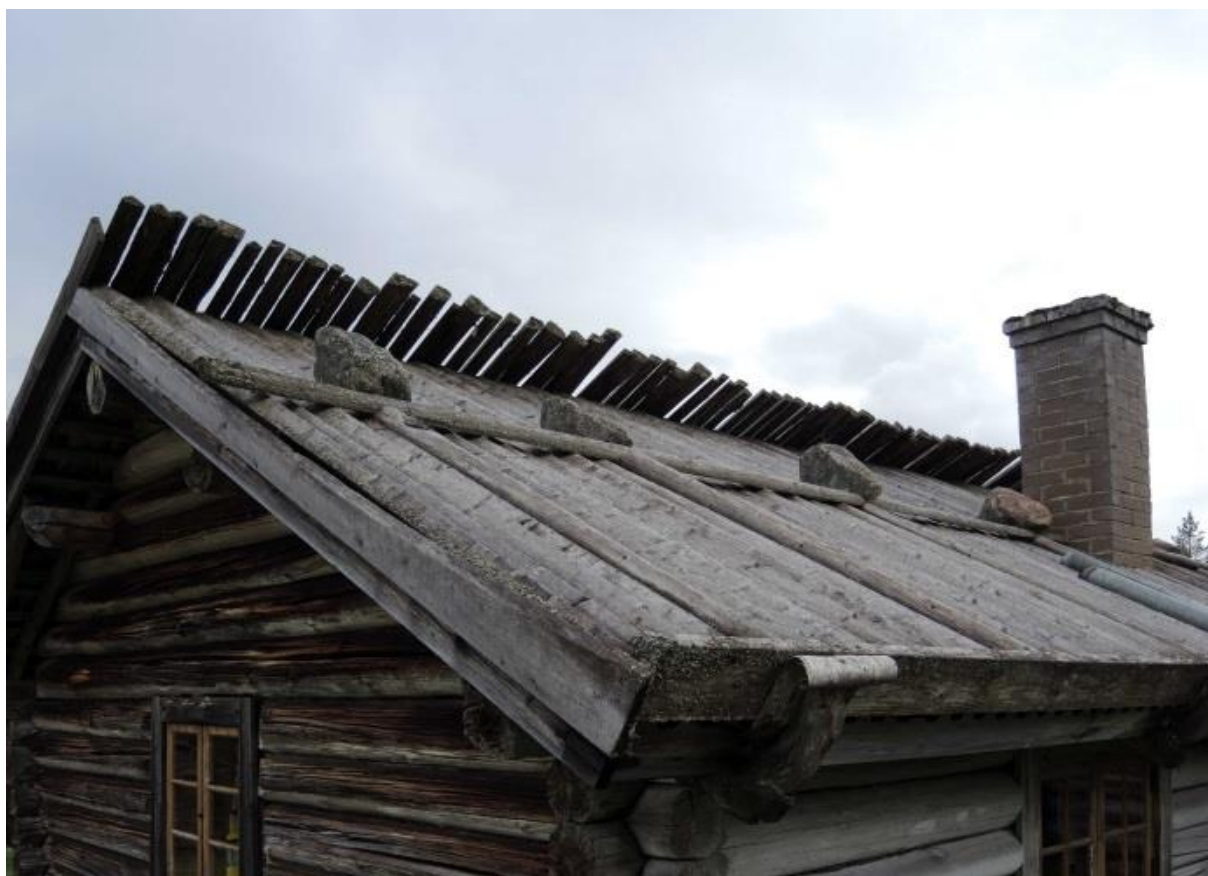
Byggnad nr 11 har ett vedtäckt plåttak med överskjutande takfall. Takveden tyngs ned av stenar som vilar på klovor mot fotbrädan.
