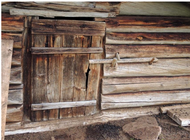
Patina i form av nötta trösklar, blankslitna lavar eller handtag låter besökaren avläsa människornas och djurens närvaro i byggnaderna. En fasad, eller som här en dörr, i ett lappverk hör till byggnadernas historia. Den övre brädan täcker ingångshålet som förstörats i och med att byggnaderna använts inom 1900-talets skogsbruk. De stora hästarna krävde en högre öppning än fäbodbrukets små lantraskor.
