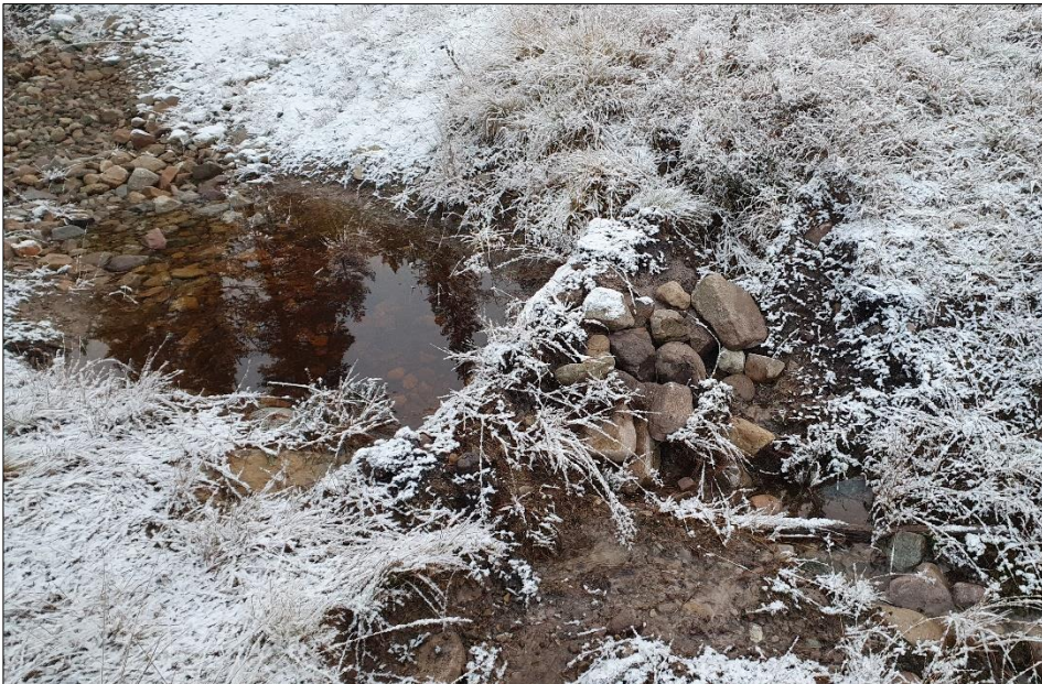
Figur 18. Exempel på utformning av dämme i dike vid en skidbacke i Idre. Foto: Sweco.
