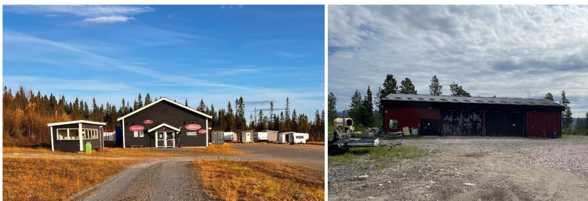
Figur 22. T.v. Skiduthyrning och husvagnsuppställning. T.h. Pistmaskinsgarage
