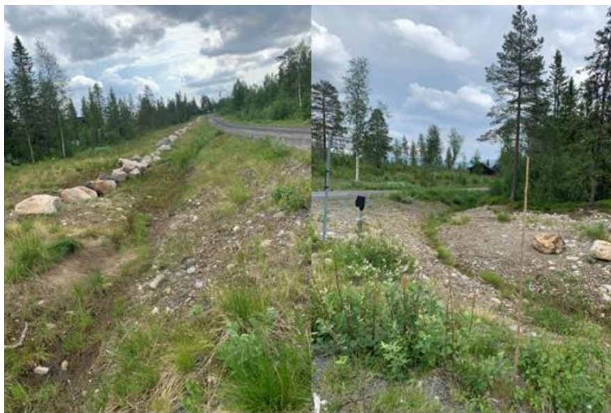
Figur 27 Befintliga diken längs vägar inom Fjätervålen (foto: Sweco, 2023).
