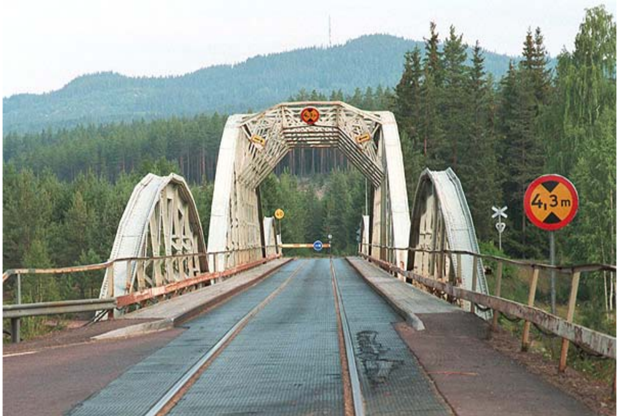
Bild nr 5. Den kombinerade lands- och järnvägsbron över Österdalälven.
